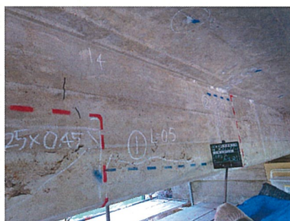
ひび割れ位置確認状況
