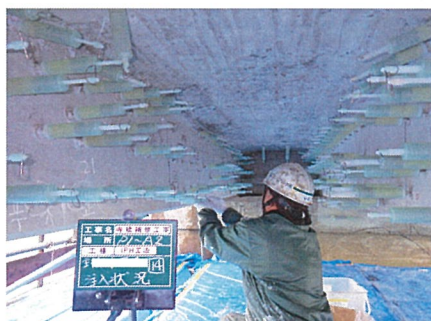
ひび割れ注入状況
