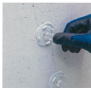
注入ポイントに台座を取り付けます。
